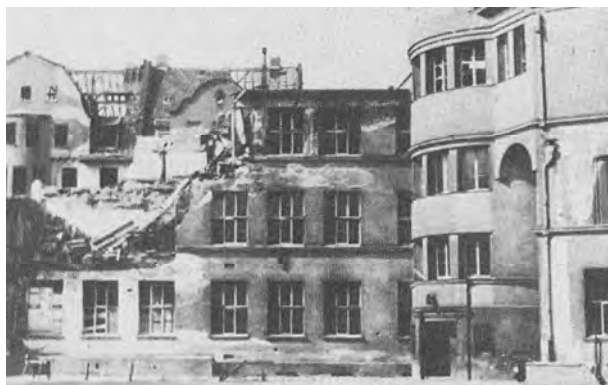
Das zerstörte Schulgebäude 1945
